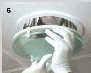
③ Hinweise zur korrekten Montage des PANOS-Downlights am Beispiel mit einer Dokoscheibe als Zubehör (Fotos: Zumtobel Staff)
