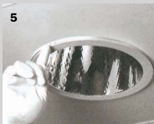
③ Hinweise zur korrekten Montage des PANOS-Downlights am Beispiel mit einer Dokoscheibe als Zubehör (Fotos: Zumtobel Staff)
