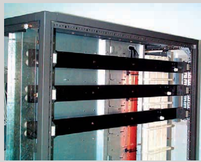
9 Störlichtbogensichere Ausführung von Haupt- und Verteilschienen (Ansicht von hinten)
