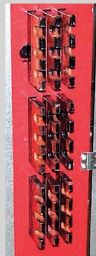
① Kompletter Schaltschrank mit beschichteten Cu-Schienen und mit weißen Isolerteilen abgedeckten Schrauben (potentielle Lichtbogenfußpunkte)
