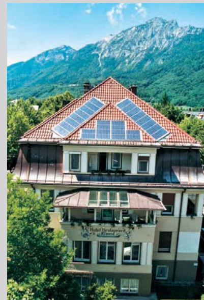
2 In landschaftlich reizvollen Gebieten können örtliche Bauvorschriften die Errichtung von Solaranlagen einschränken
