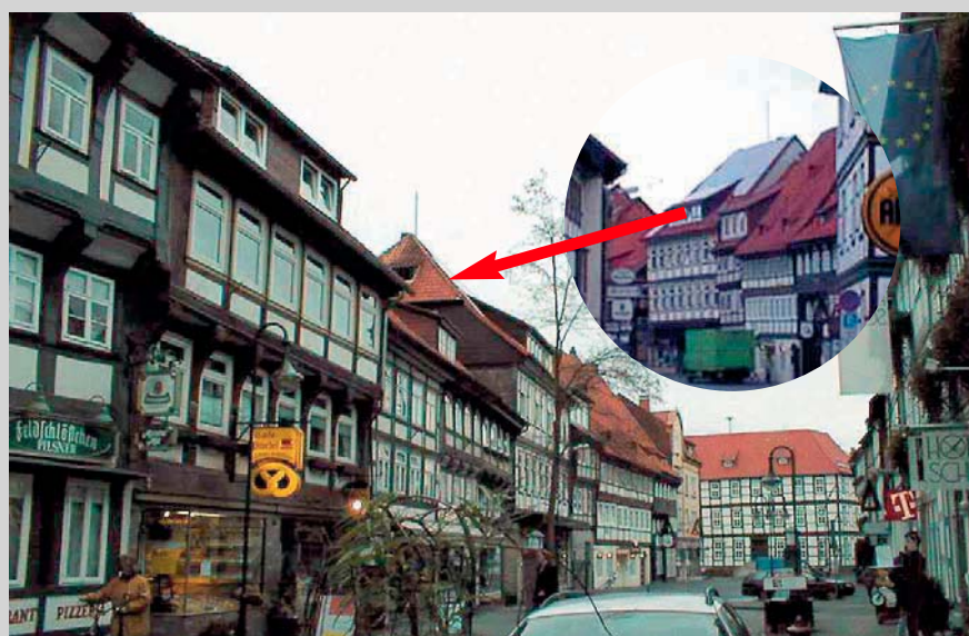
1 Besonders in historischen Altstädten sind die Auflagen des Denkmalschutzes zu beachten
