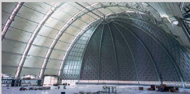
1 Luftschiffhalle des neuen CargoLifters (etwa 60 km südlich von Berlin)
