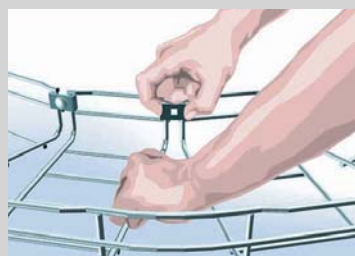
③ Fixierung der gebogenen Rinne
