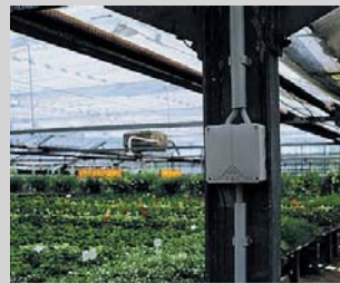
1 In Gewächshäusern ist je nach Nutzung in IPX5 (strahlwassergeschützt) zu installieren
