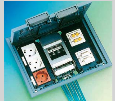
5 Installation von RJ45-Anschlüssen im Unterflurbereich
