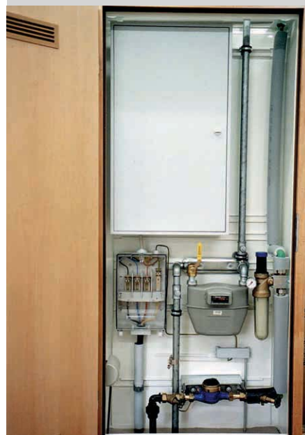
② Beispiel einer ausgeführten Hausanschlussnische nach DIN 18012
