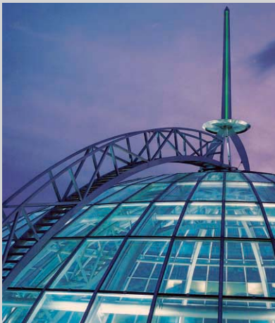
12 Beleuchtung des Pylons im City-Carré Berlin (Foto: LBM Lichtleit-Fasertechnik)
