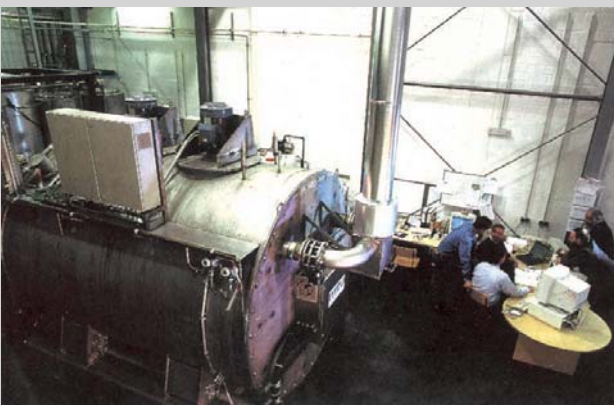
⑨ Demonstrationsprojekt einer 280 kW elektrisch leistenden Hochtemperatur-MCFC-Anlage, die Strom und Prozessdampf in die Netze der Universität Bielefeld einspeist. Charakteristisch ist der große Kessel, der alle „heißen Teile“ aufnimmt. Ergebnisse: Verfügbarkeit 75 %, el. Wirkungsgrad 47 %, Gesamtwirkungsgrad 77 % (Quelle: MTU)
