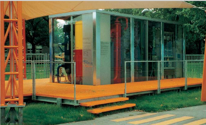
⑥ Während das Innere des neuen 250 kW-PEMFC-BHKW der Bewag im verschlossenen Container unsichtbar bleibt, können die Einzelteile des Vorläufers mit einer 200 kW-PAFC im BZ-Innovationspark 1) in Ruhe betrachtet werden.
