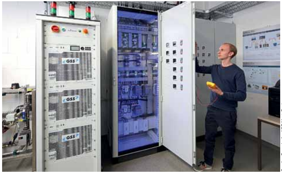
3 Arbeiten am zentralen Verteilerschrank des DC-Testnetzes am Fraunhofer IISB
