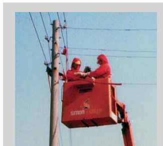
1 Bei Arbeiten an unter Spannung stehenden Freileitungen sind die erforderlichen Schutzausrüstungen einzusetzen
