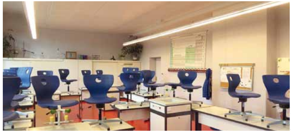
4 Beleuchtung eines Chemie-Unterrichtsraumes im Landesgymnasium LATINA August-Hermann-Francke in Halle/Saale, einlampige Reflektorleuchten mit Leuchtstofflampen T5 HE 35 W/840 (Länge 1449 mm), errichtet 2015
