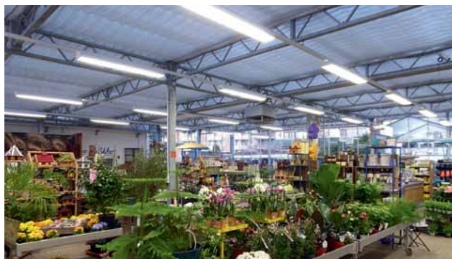
2 Beleuchtung der Innenanlage eines Garten-Centers mit zweilampigen Rasterleuchten und tief-breitstrahlender Lichtverteilung. Bestückung: Leuchtstofflampen T8 / 58 W, EVG-Betriebsweise, errichtet 2011
