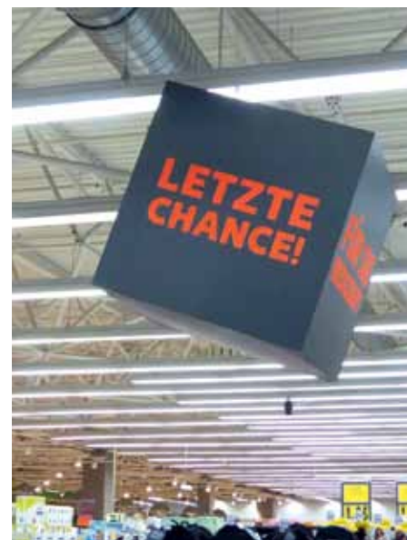
1 Beleuchtung eines großen Supermarktes mit einlampigen Leuchten tief-breitstrahlend in Lichtbandanordnung. Bestückung: Leuchtstofflampen T8 / 58 W. Der Würfel weist auf reduzierte Warensortimente hin
