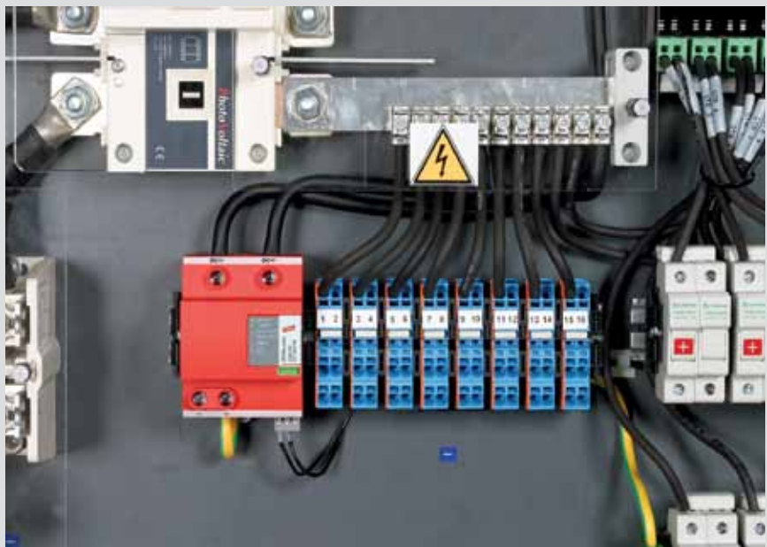
4 PV-Generatoren bis zu bestimmten Systemleistungen können versicherungsfrei sowohl am Wechselrichter als auch im Generatoranschlusskasten (GAK) geschützt werden
