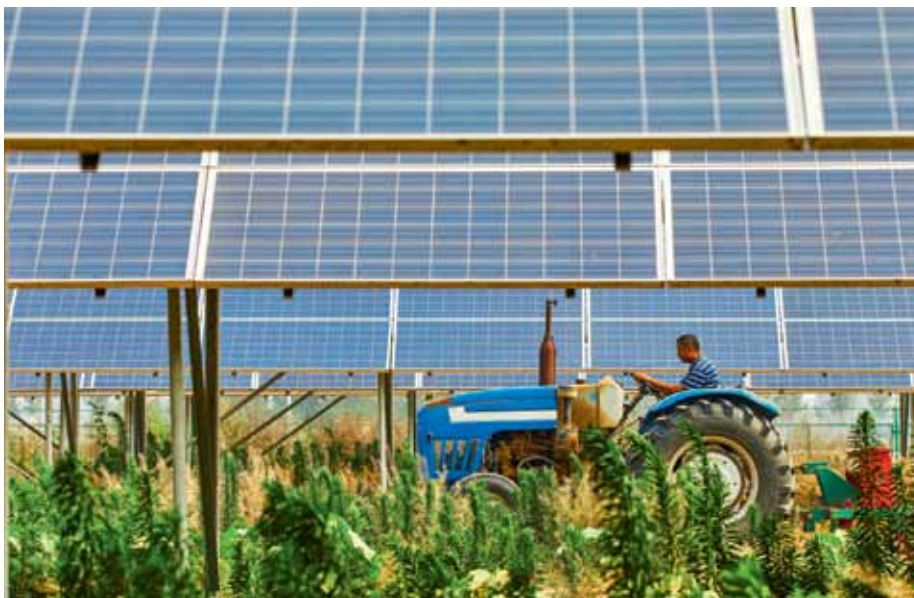
1 PV-Module, die wie ein Dach über der landwirtschaftlichen Nutzfläche angeordnet sind
