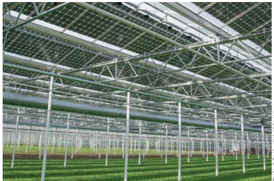
2 PV-Module, die an der Konstruktion von Gewächshäusern angebracht sind
