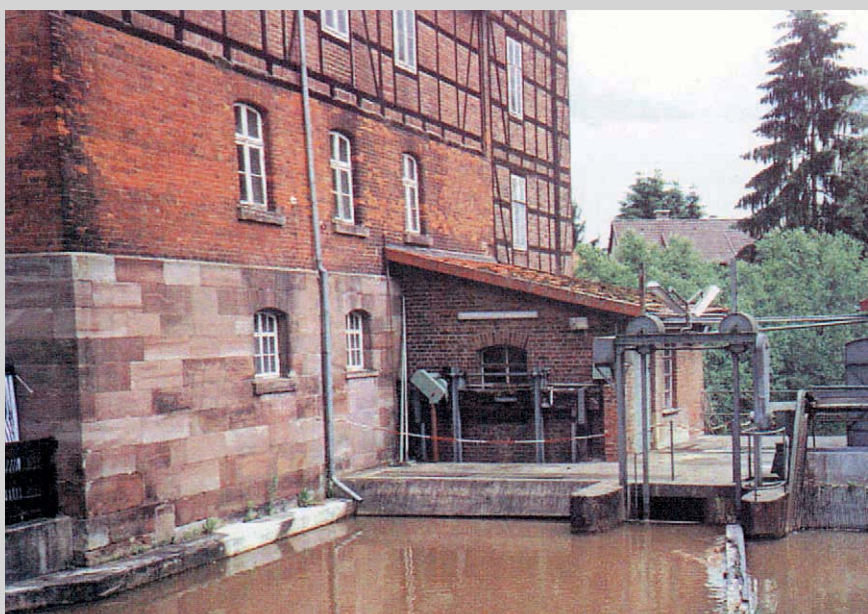
❶ Wasserkraftwerk der EAM in Katlenburg, 60km nordöstlich von Kassel am Rand des Harzes. Nutzgefälle h = 3,2 m, Wassermenge Q=4,5 m 3 /s, Turbinenleistung P=105 kW
