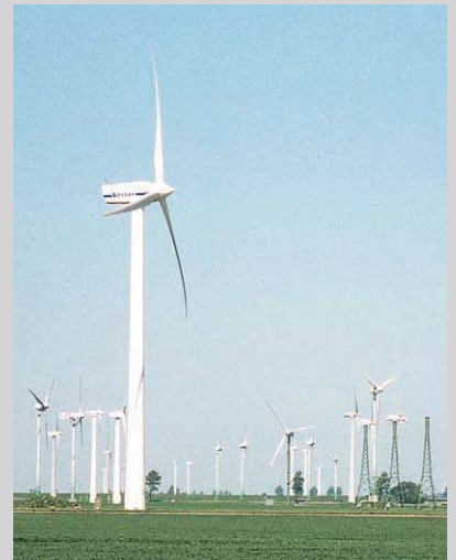
1 Zum 30. Juni 2000 drehten über 8370 Windkraftanlagen ihre Rotoren in den Wind, die gesamte installierte Leistung betrug rund 4970 MW
