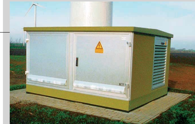
Bild 1 Fabrikfertige Beton-Netzstation für Windkraftanlagen (WKA)
