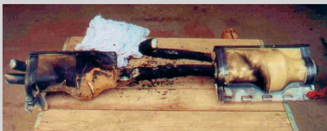
❶ Zerstörte Kabelabzweigmuffe nach dem Auslösen des Lichtbogens
