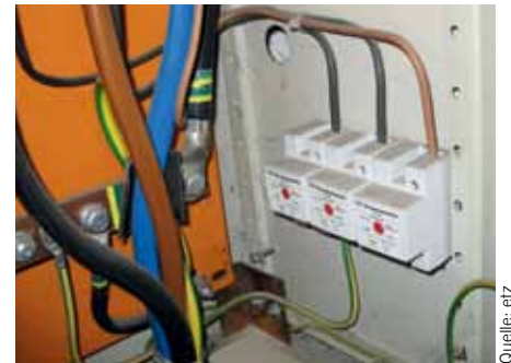
Mangelhafter Einbau von Überspannungsschutzgeräten
