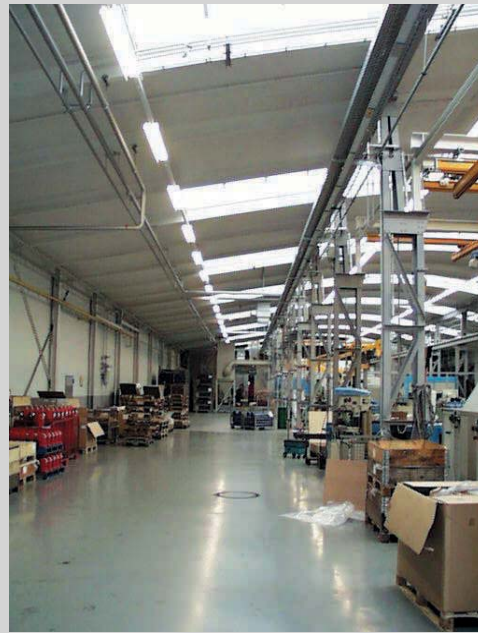
1 Teilansicht Produktionshalle mit Lichtband und Dachfenster
