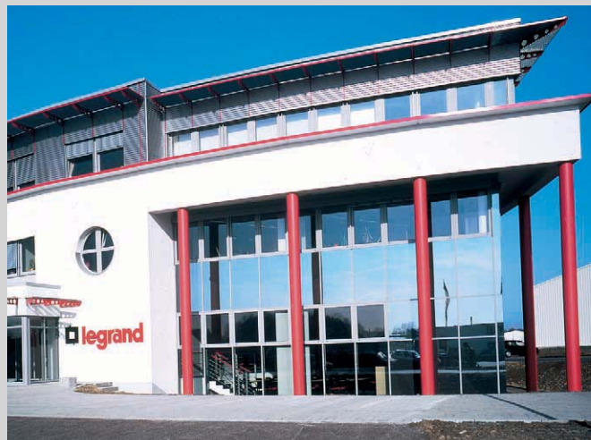
③ Verwaltungsgebäude in Soest
