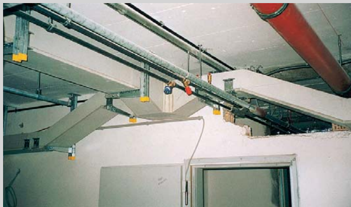
8 Bei einer rechtzeitigen Koordination aller Gewerke lassen sich solche Versprünge vermeiden
