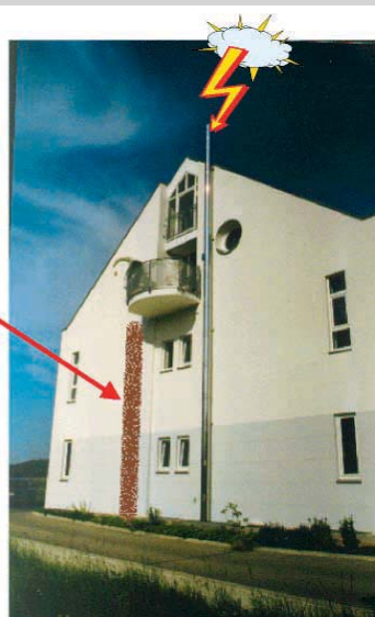
① Blitzschlag in Edelstahlkamin eines Bürogebäudes
