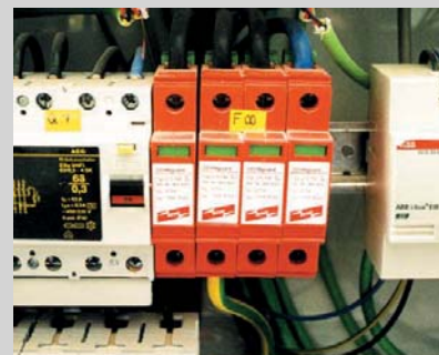
5 Überspannungsschutz für 230/400-V-Versorgung einer EIB-Verteilung
