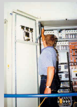
2 bis 4 Die Durchgängigkeit des Schutzleiters wurde an allen relevanten Punkten geprüft
