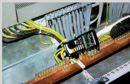
5 und 6 Die Messung der Ableitströme wurde als Alternative zur Isolationsmessung angewandt
