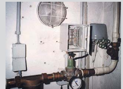
⑨ Installation von Überspannungsableitern am Telekomkabel
