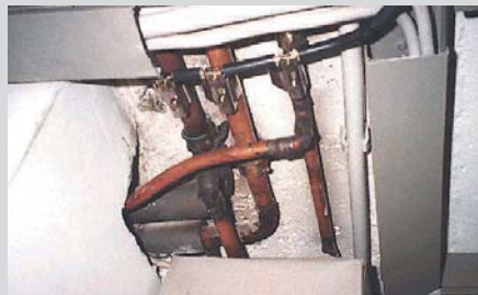
⑦ Installation ordnungsgemäßer Potentialausgleichsanschlüsse
