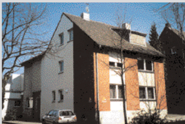
1 Wohn- und Geschäftshaus, dessen Blitzschutzanlage geprüft und festgestellte Mängel beseitigt wurden
