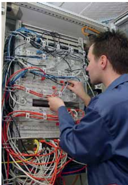
Arbeiten am Netzwerkschrank
