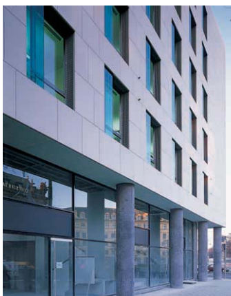
Sieht man seine Geschichte nicht mehr an: der aus den fünfziger Jahren stammende und völlig sanierte Bau der VICTORIA
