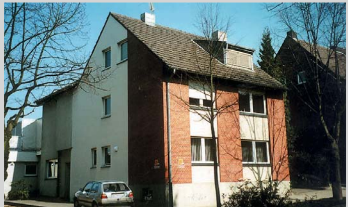
1 Wohn- und Geschäftshaus dessen Blitzschutzanlage geprüft wurde
