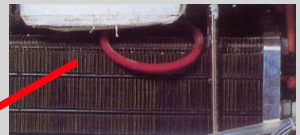
3 Hausenergiezentrale mit einer Brennstoffzelle Typ PEM für 3 kW elektrisch und 8 kW thermisch. Oben der Zellstapel, bestehend aus vielen scheibenförmigen einzelnen Zellen.
