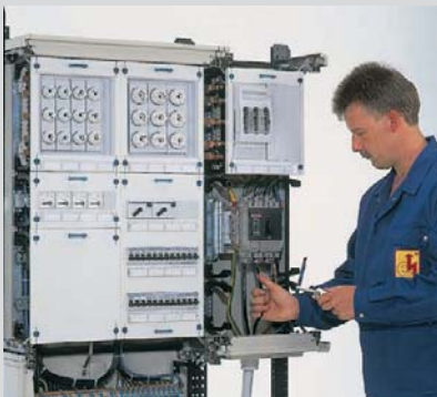
7 Nach Einschieben der Wände, in denen sich Flanschplatten befinden, erfolgt der Kabel- und Leitungsanschluß
