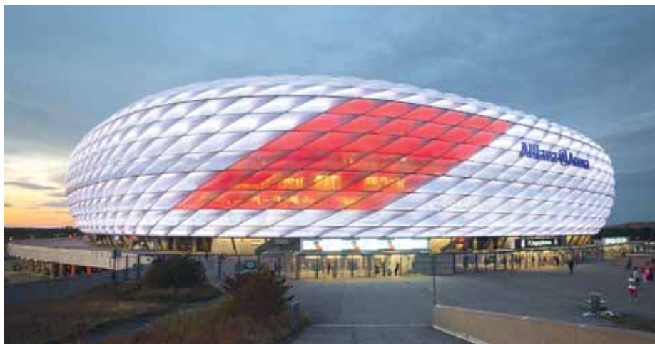
Ein neue LED-Fassadenbeleuchtung der Allianz-Arena in München lässt sich digital in Echtzeit steuern und beherrscht 16 Millionen Farben
