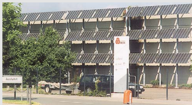
2 An der Südwand der Halle 3 ging rechtzeitig zu Messebeginn Bayerns größte Solaranlage in Betrieb
