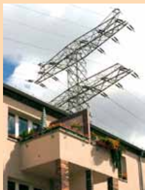
Starkstromleitung über einem Wohnhaus
