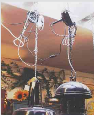
16 Nicht normgerechter Ausstellungsstand für gebrauchte Leuchten in einem Verkaufsladen
