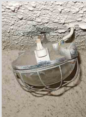
15 Offensichtliches Versagen der Befestigung
