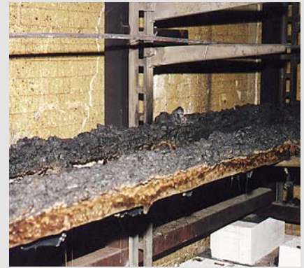
3 Trasse nach Abschluß der Versuche. Man sieht den aufgeschäumten Dämmschichtbildner; ein Weiterbrennen hat nicht stattgefunden
