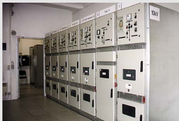
3 Im Werk ausgebaute Betonzelle
