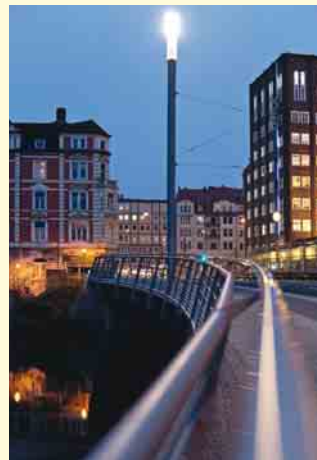
Die Lichtrohre befinden sich an 10 m hohen Masten
