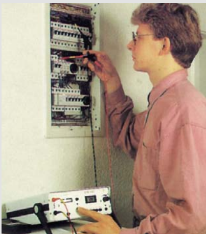
❷ Stoßspannungsprüfung an einem Verteiler mit dem Prüfgerät SIG 200
