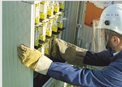
➎ Schutz der linken Hand beim Einsetzen von NH-Sicherungen
