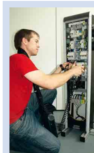
1 Einsatz von Messtechnik an Ladesäulen Foto: etz Stuttgart
