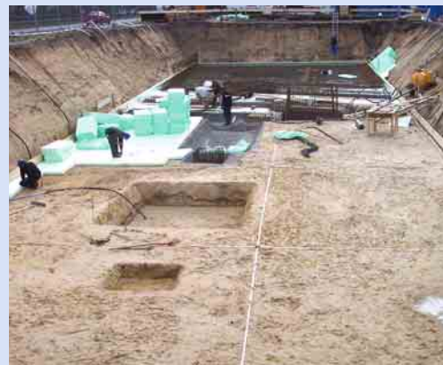
2 Ringerder bei Perimeterdämmung
