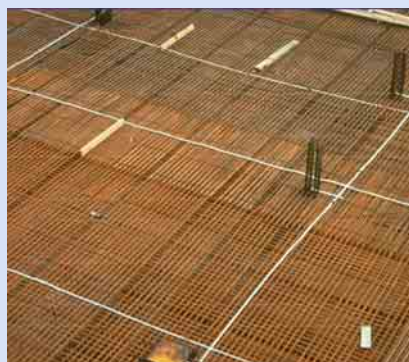
3 Maschenförmige Verlegung
