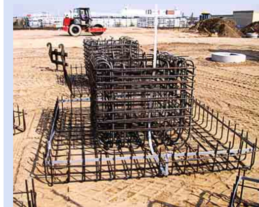
1 Fundamenterder Einzelstütze
