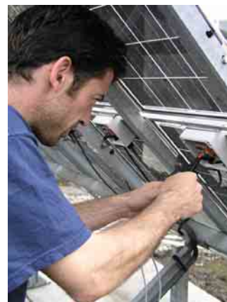
1 Messtechnische Überprüfung der PV-Anlage
