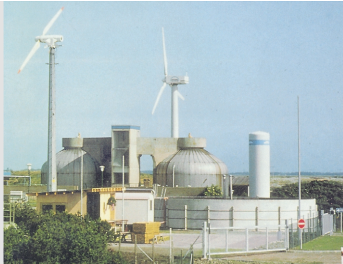
④ Windkraftgestützte Kläranlage. Das in Faultürmen gewonnene Klärgas wird in Behältern gesammelt. Ein vor Ort installiertes BHKW leistet 26 kW el und 78 kW th . Die Wärme wird zur Beheizung der Faultürme genutzt. (Quelle: Schleswig AG)
