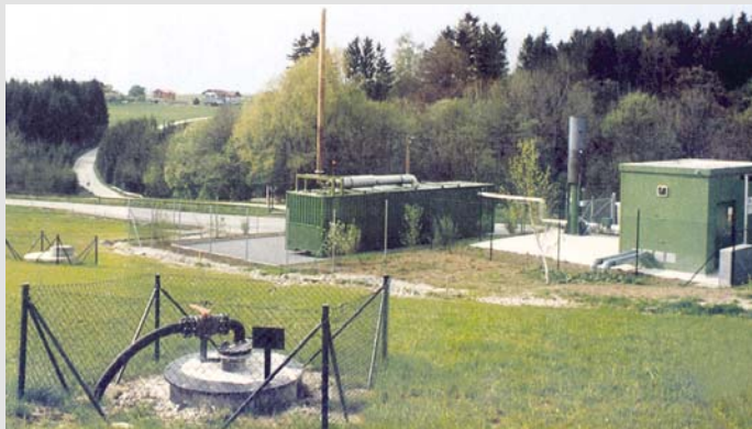
③ Deponiegasanlage der Isar-Amper-Werke AG München. BHKW (Bildmitte) 250 kW. Im Vordergrund der Gasanschluß an die darunterliegende Deponie. (Quelle: Isar-Amper-Werke)
