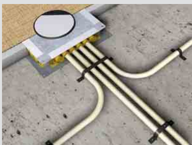
④ Verlegung von Elektroinstallationsrohren auf einer Rohbetondecke
