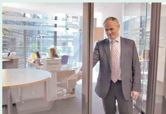
2 Die Lichtschalter sind komplett kabellos installiert. Dies ermöglicht auch eine Anbringung auf den Glaswänden
