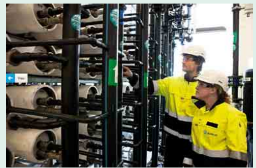
4 Druckrohre mit aufgerollter Membran
