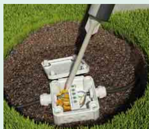
2 Das Vergießen eines Bauteils ist innerhalb von 20 Minuten möglich
