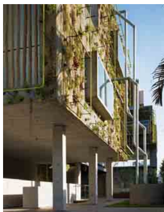
Bürogebäude in Sao Paulo mit einer innovativen Lösung für die Regelung des Wasserhaushalts und der Klimatisierung
