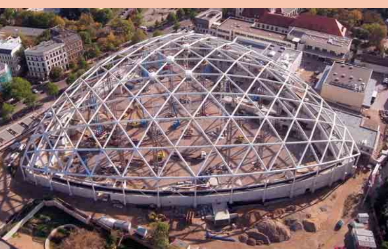
❶ Baustelle Gondwanaland in Leipzig – eine technische und energetische Herausforderung für gemäßigte Breiten
